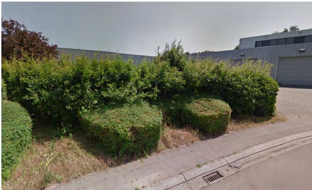
Figuur 26: De struiken werden hier verhoogd aangelegd, waardoor water afkomstig van de wegnis hier niet naar kan afstromen. Daarenboven zal de straatkolk ervoor zorgen dat het water meteen op het RWA-stelsel terecht komt (Bron: Google Streetview ter hoogte van Arthur de Coninckstraat 2).
