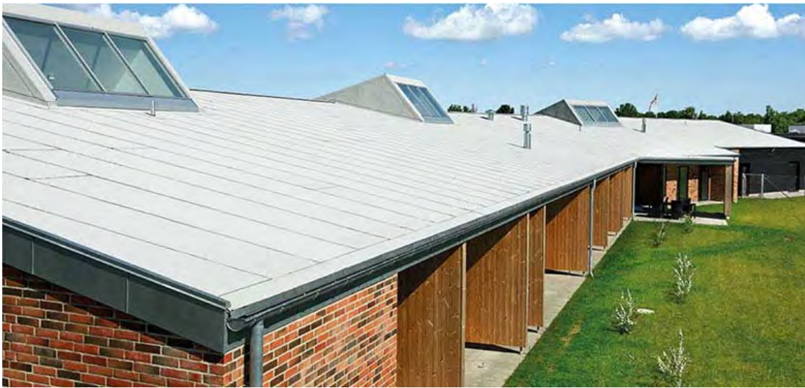
Cool Roof - voorbeeld van een dak met hoog albedo - https://energyhawksusa.com/cool-roofs-help-keep-energy-costs-down/
