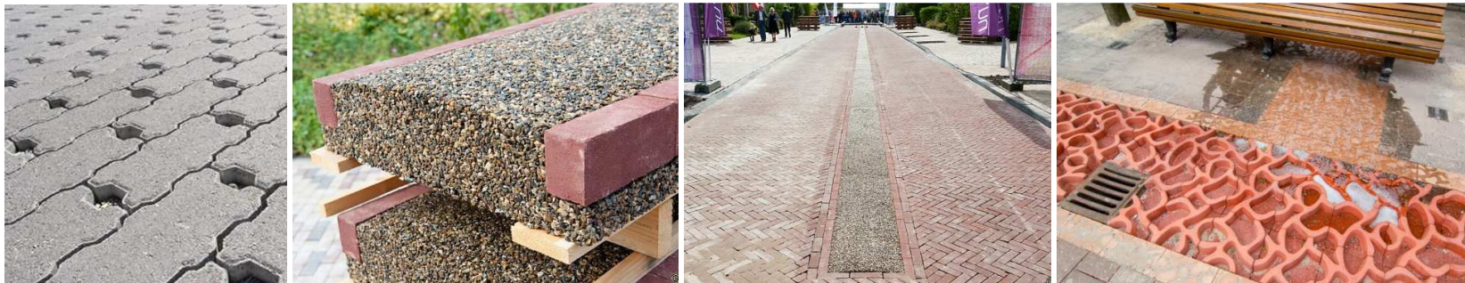
Waterpasserende verharding, een granudrain en de rainaway tegel.
